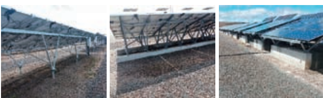
写真11 様々な種類の架台と基礎
