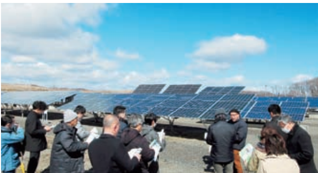
写真9 30種類の太陽光パネルが設置されている
