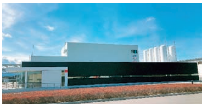
写真2 福島水素エネルギー研究フィールド
