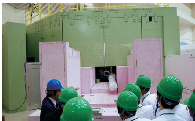
写真5 『物質・生命科学実験施設』内部。建設中の実験機器の内部を覗き込むことが出来た。実験が始まると放射化のためこんなには近づけない。
