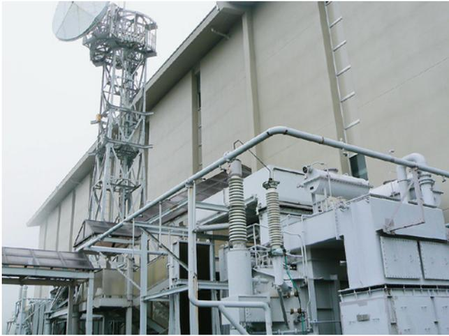
月に実証試験を開始した、定格出力2千kWの発電施設もあります。これは、上記の発電方法とは異なり、沸点が36℃と低いペントンを熱交換器で加熱、蒸発させ、その蒸気を用いて発電させる方式を採用しています。従来の地熱発電方式では利用できなかった低温度の蒸気・熱水での発電が可能となるため、熱水の温度と圧力が減衰して現在は商用発電には使われていない蒸気井を再利用しています。
