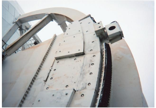
アンテナと受信機のある下部機器室は台座に据え付けられて6個の水平回転用車輪で支えられています。総重量は700トンになりますが、2台のモータにより水平回転を行うことができます。水平方向の回転速度は1周20分程度で、上下方向の首振り速度も同程度だそうです。観測を開始してから20年以上になりますが、20mの基礎を持つ土台が毎年0.7mm程度ずつ傾くため、2000年に大改修を行い、回転レールを設定し直したそうです。また、この見学の翌日からペンキ塗りを行う予定とのことでした。
